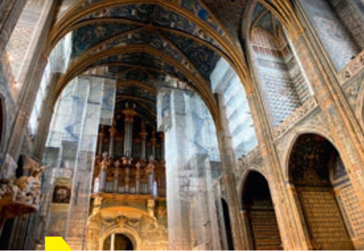
Les échafaudages sont actuellement de part et d'autre de l'orgue.
