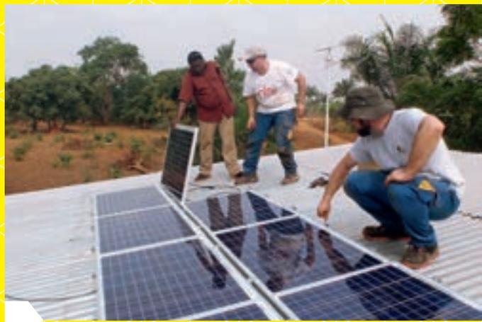
*La pompe immergée à 70 mètres est alimentée par des panneaux photovoltaïques.*
